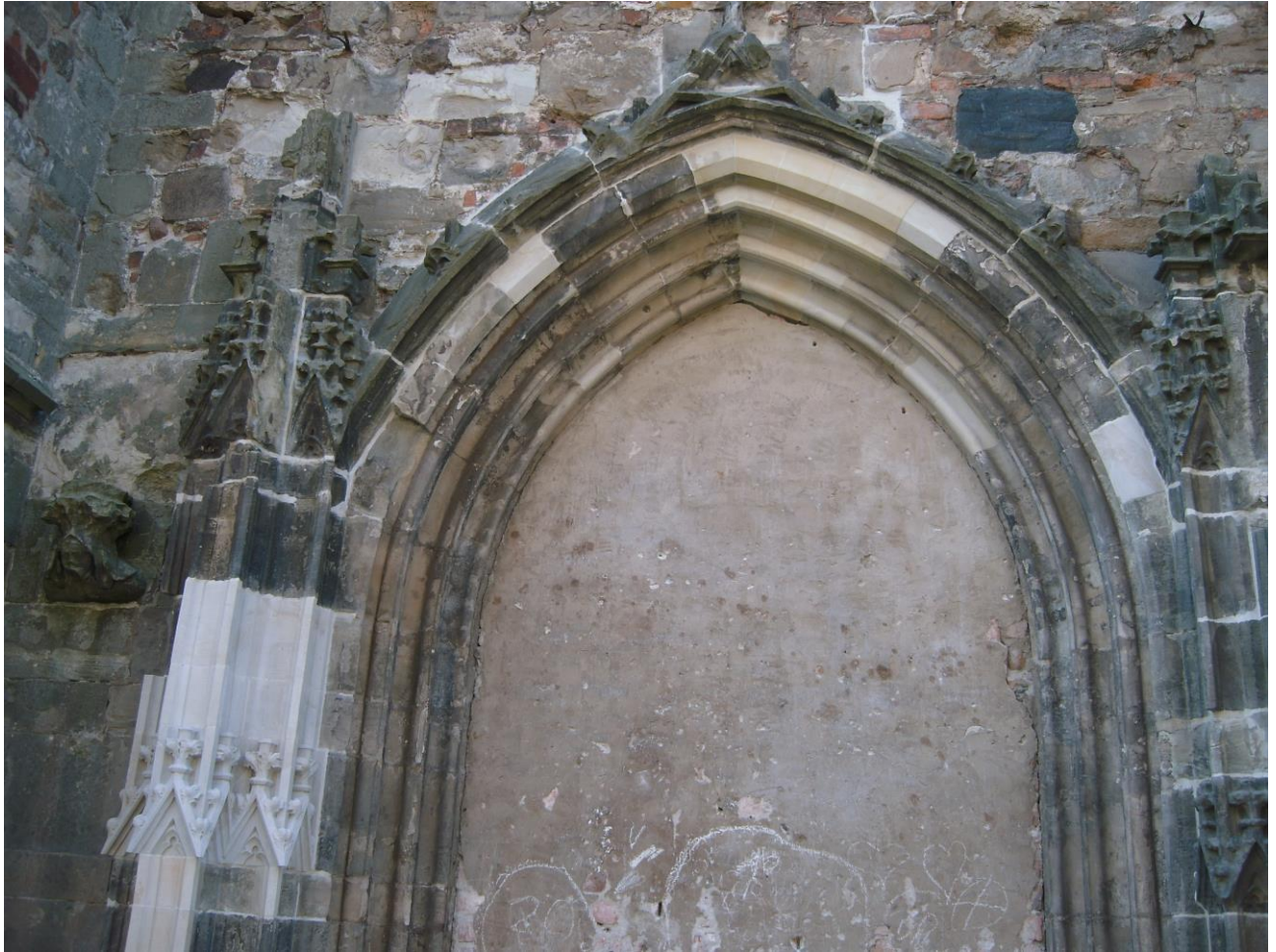
Bild 5: Nordportal am 3. August 2018 – Teil-Erneuerung der Bogenrippen
