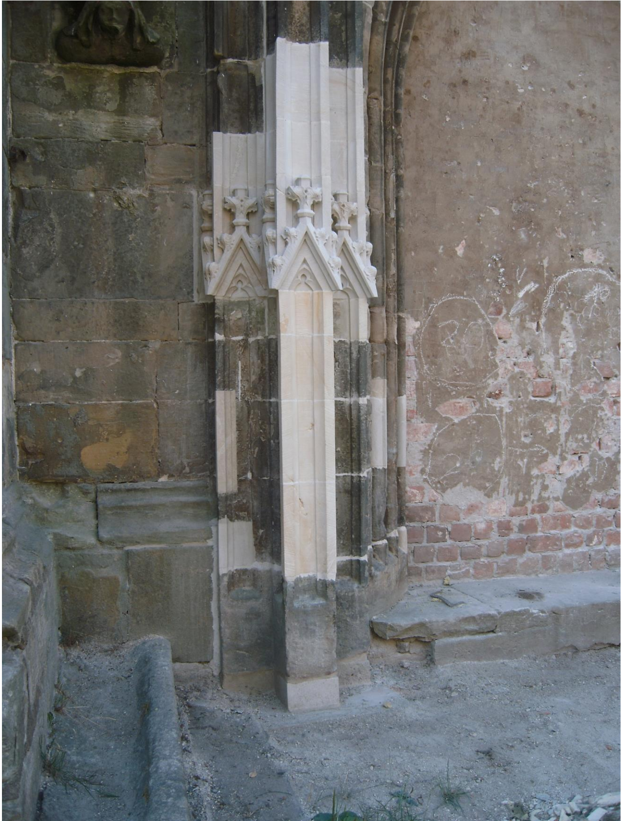
Bild 3: Nordportal am 3. August 2018 – östliches Gewände
