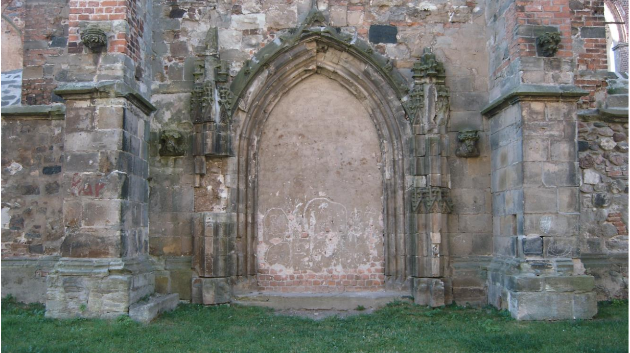
Bild 1: Nordportal vor Maßnahmebeginn im März 2018
