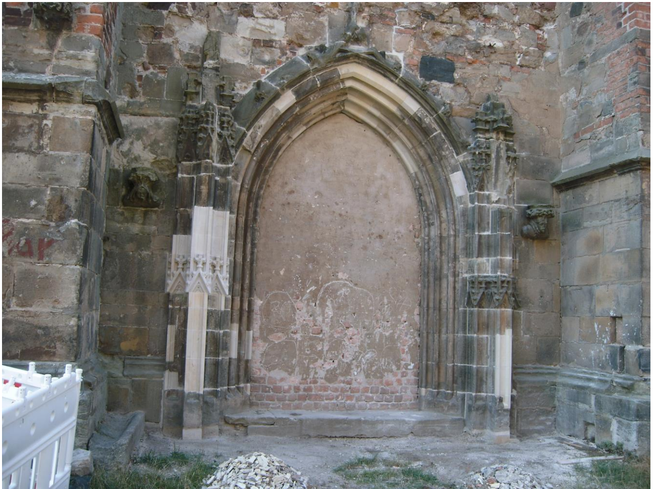
Bild 2: Nordportal am 3. August 2018
